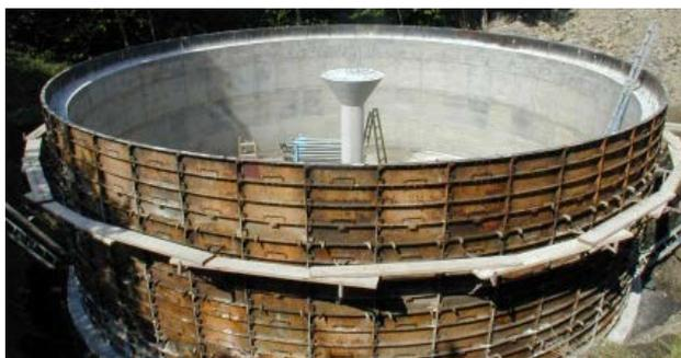
Ein unterirdischer Löschwasserbehälter (ULB) ist ein künstlich angelegter überdeckter Löschwasserbehälter mit Löschwasserentnahmestelle.
