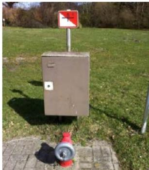
Außer nach der Betriebsart werden die Löschwasserbrunnen nach ihrer Ergiebigkeit eingeteilt. Es muss eine Wasserentnahme von mindestens 400 l/min (= Löschwasserbrunnen – klein) über mindestens 3 Stunden möglich sein.
